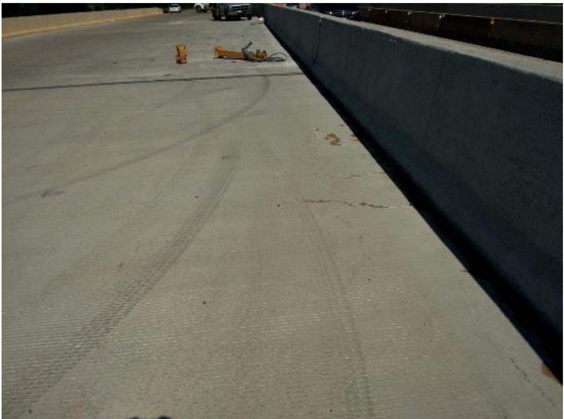
桥面护栏，浇筑的并不直，弯弯曲曲的。
