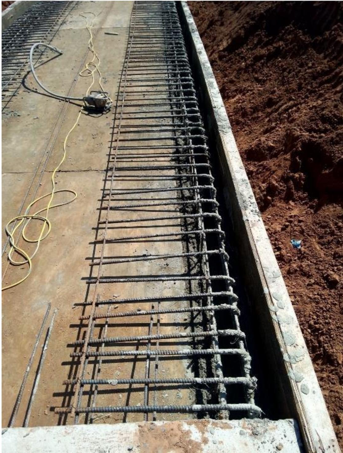
他这个浇筑的流程和国内的不太一样，国内是侧板和顶板一次浇筑成型，他这里先浇筑了侧板，再浇筑顶板，费了不少事。浇筑顶板之前结合面凿毛、钢筋除锈，顶板垃圾清理什么的很麻烦。而且他的所有模板都是竹胶板，国内使用钢模
